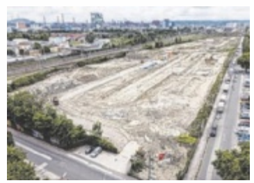
Die neue Halle entsteht in der Linzer Raimundstraße. Foto: ÖBB/MecGreenie
