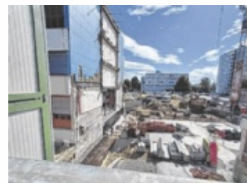
Bereits 2025 starteten die Bauarbeiten am Peuerbach-Gymnasium. Foto: Steiner
