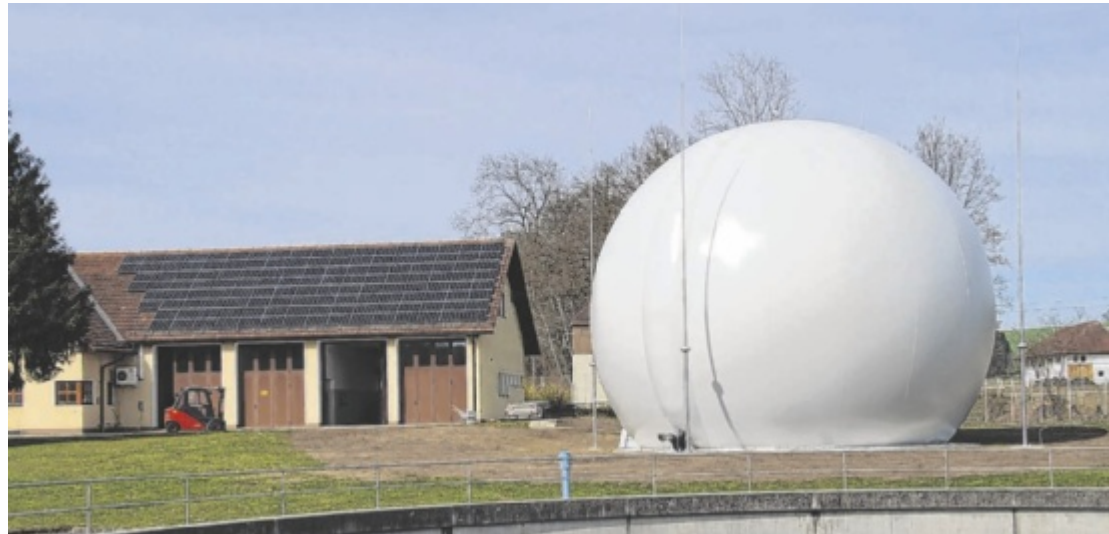
In Kombination mit der PV-Anlage sorgt der Gasspeicher für eine optimale Energieversorgung.
