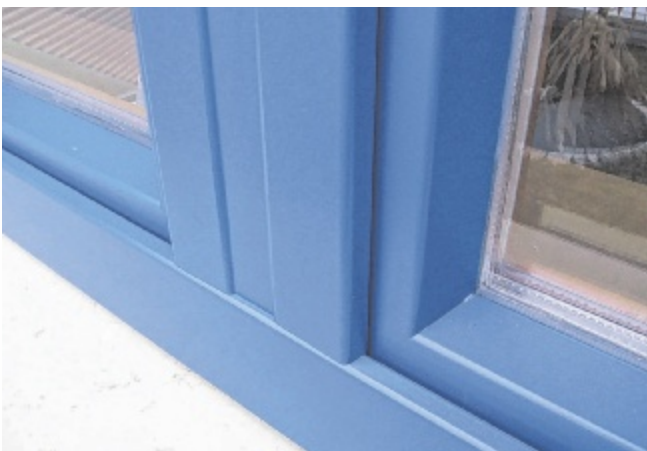
Saniertes Fenster mit Aluminiumverkleidung
