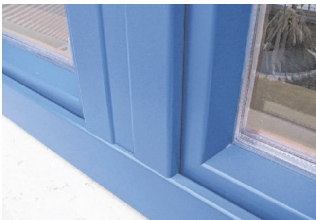
Saniertes Fenster mit Aluminiumverkleidung
