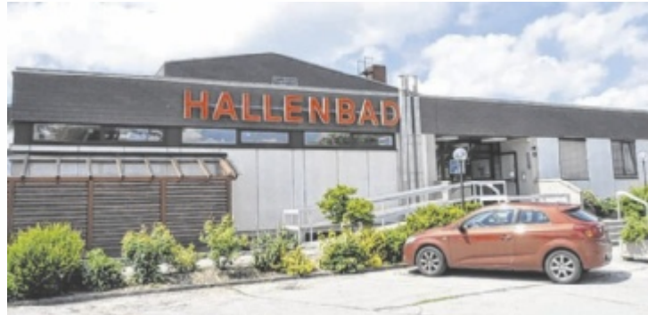
Sanierungsbedarf im Hallenbad Freistadt
