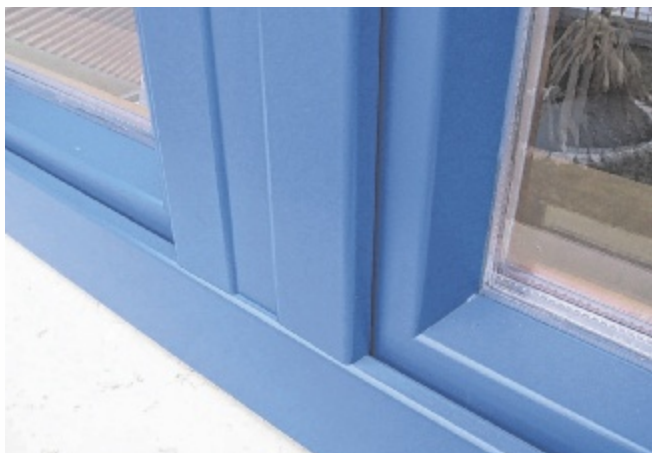
Saniertes Fenster mit Aluminiumverkleidung
