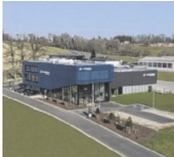
Das neue Firmengebäude in Peuerbach Foto: Lehner Liftechnik GmbH
