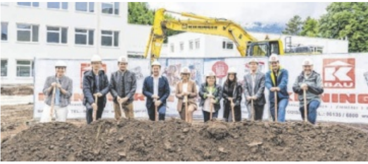
Mit dem Spatenstich fiel der Startschuss für die neue Sporthalle.
