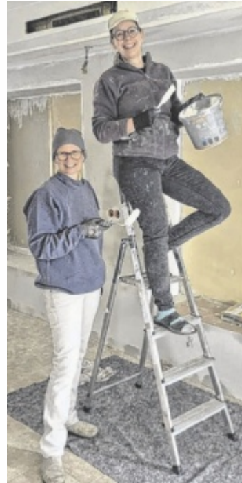
Der Verein „BadeZimmer – Verein für ein lebendiges Dorf“ hat das bisherige Freibadbuffet renoviert.
