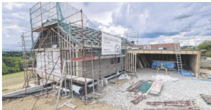
Walding: Ein modernes m-haus in Holzbauweise in Hanglage
