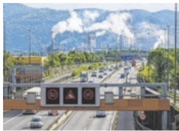
Bis 2030 wird saniert.
