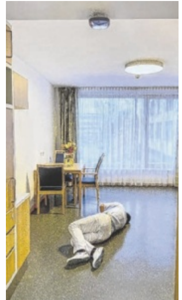
Moderne Sensoren (siehe Gerät an der Decke) erkennen Stürze und alarmieren das Pflegepersonal. Foto: Stadt Linz
