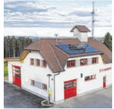
Das sanierte Zeughaus mit dem Zubau.
