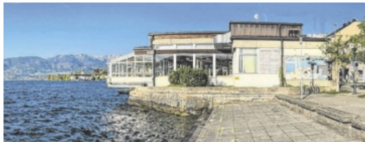
Nachfolger für „Baumgartner-Gebäude“ wird gesucht. Foto: Stadtgemeinde Gmunden
