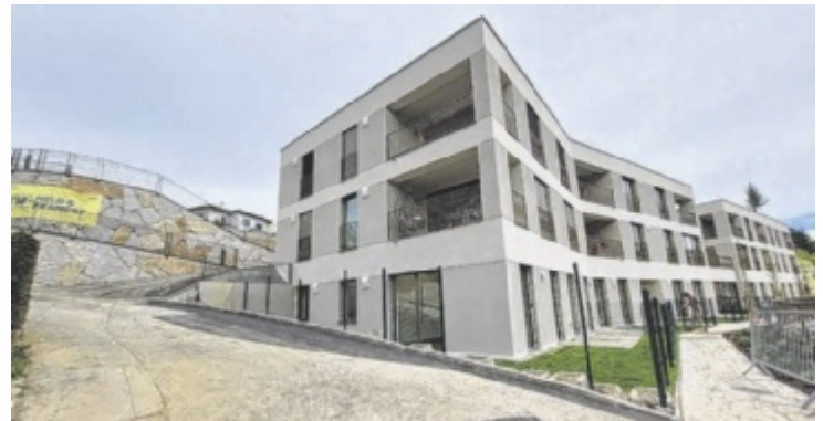
Die Wohnungen sind auf dem neuesten Stand der Bautechnik.
