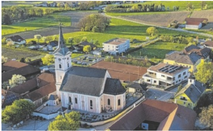
Das neue Bildungszentrum und das Tennisheim befinden sich mitten im Zentrum neben der Kirche. Foto: Gemeinde
