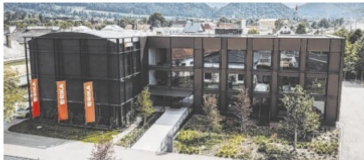
Modernisierte RIKA Innovative Ofentechnik Zentrale in Micheldorf
