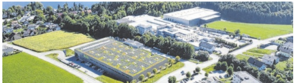
Das Rohrwerk der Wuppermann Metalltechnik GmbH gilt als eines der modernsten Anlagen in Europa. Foto: Wuppermann AG
