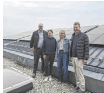
PV-Anlage der Mittelschule Foto: Gemeinde
