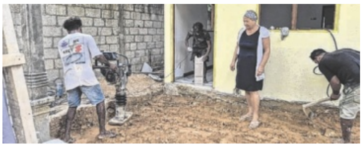
Zwei neue Häuser und einige Anbauten sind in Unawatuna für arme Familien errichtet worden.
