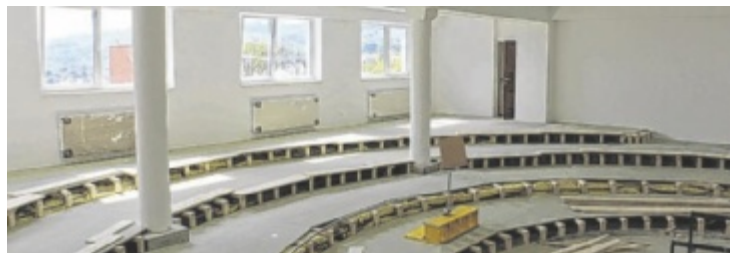
Die Stufenkonstruktion im neuen Proberaum ist bereits erkennbar.
