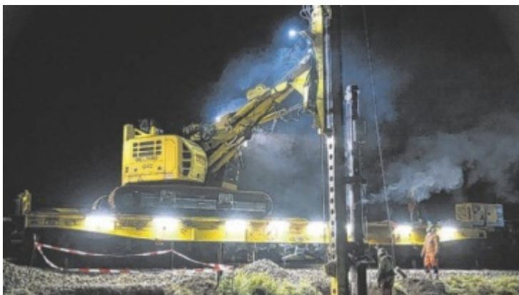
Der Großteil der Arbeiten für die Elektrifizierung findet nachts statt. Foto: ÖBB_Pleschko
