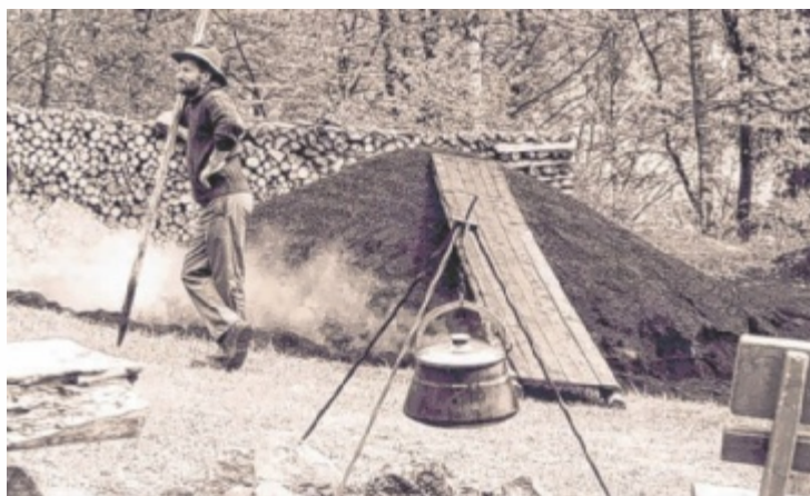
Nach 20 Jahren raucht wieder ein Kohlemeiler am Großdöllnerhof.
