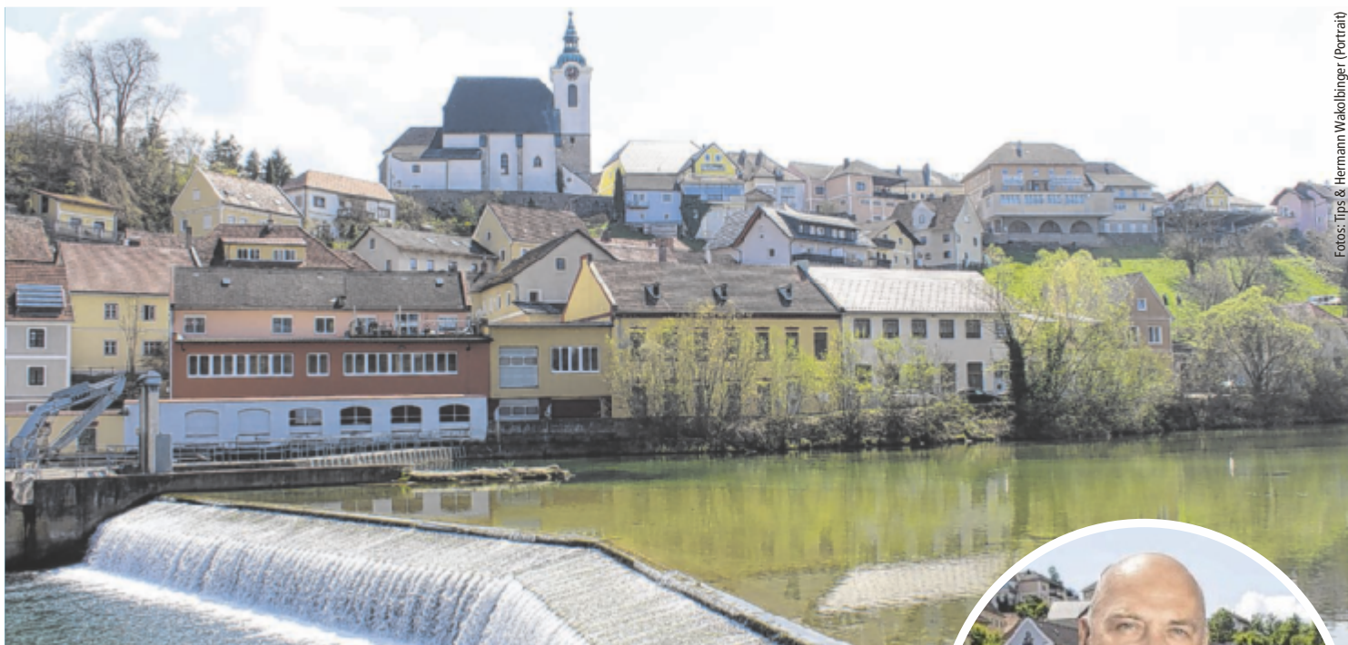
In Steinbach an der Steyr wird derzeit unter anderem an einem neuen Nahversorger gearbeitet.
