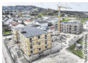
Errichtet werden zwei dreigeschobige Wohnhäuser mit je 12 Mietwohnungen.
