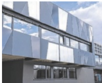
Die Arbeiten an der Fassade stehen kurz vor dem Abschluss. Fotos: MKW
