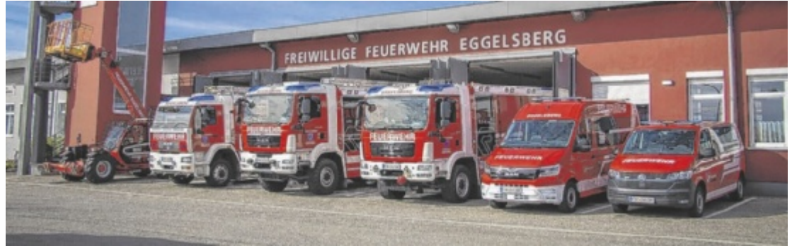
Die Feuerwehr Eggelsberg ist in einem modernen Einsatzzentrum stationiert.
