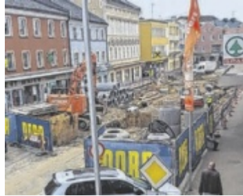
Die aktuelle Baustelle
