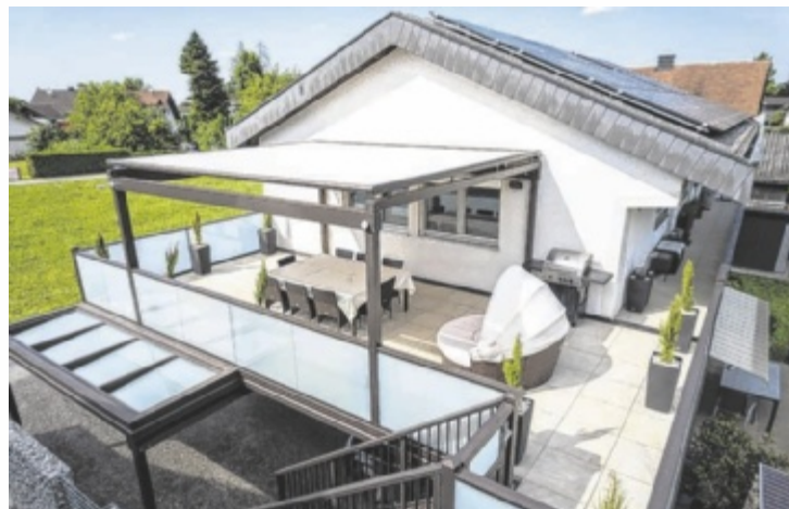
Individueller Anbaubalkon mit Überdachung und Stiegenaufgang
