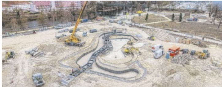
Blick auf die Baustelle Seerosenteich
