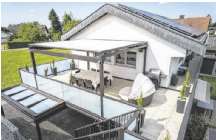
Individueller Anbaubalkon mit Überdachung und Stiegenaufgang
