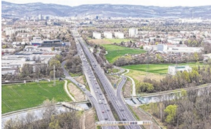
Die A7-Strecke vom Knoten Linz bis zur Anschlussstelle Franzosenhausweg wird generalsaniert, die Bauarbeiten sind bereits gestartet. Foto: ASFINAG
