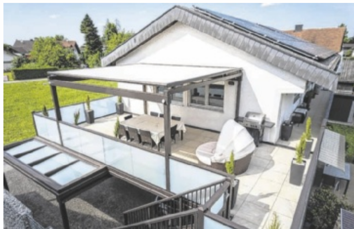
Individueller Anbaubalkon mit Überdachung und Stiegenaufgang
