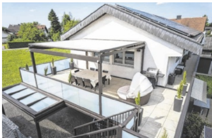
Individueller Anbaubalkon mit Überdachung und Stiegenaufgang
