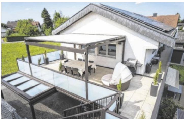
Individueller Anbaubalkon mit Überdachung und Stiegenaufgang
