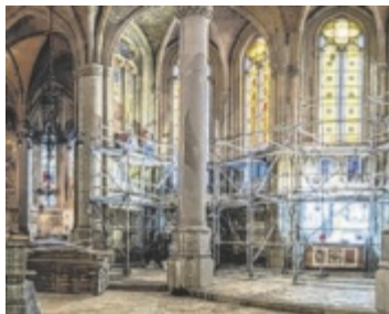
Die Restaurierarbeiten sind fast abgeschlossen. Foto: Diözese Linz / Johannes Kienberger
