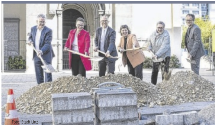
Spatenstich am Martin-Luther-Platz Mehr Grün, mehr Schatten, mehr Aufenthaltsqualität: Die Neugestaltung des Martin-Luther-Platzes hat begonnen. Die Fertigstellung ist Ende Oktober geplant. Am Foto (v. l.): Stadtentwicklungsdirektor Hans-Martin Neumann, Umweltstadträtin Eva Schobesberger, Bürgermeister Dietmar Prammer, Pfarrerin Veronika Obermeier-Siegrist, Kuratorin Irmgard Ostermann, Martin Urmann (Vorsitzender Bauausschuss der evangelischen Pfarrgemeinde)
