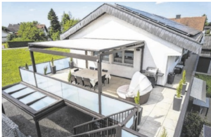
Individueller Anbaubalkon mit Überdachung und Stiegenaufgang
