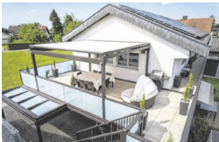
Individueller Anbaubalkon mit Überdachung und Stiegenaufgang
