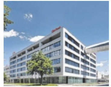
Zubau der Oberbank-Zentrale an der Donaulände Linz. Foto: Oliver Hallwirth / raumpixel
