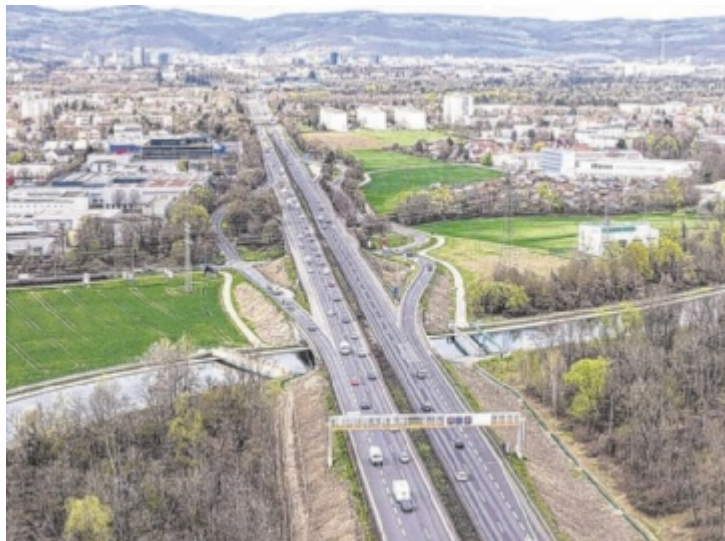
Die A7-Strecke vom Knoten Linz bis zur Anschlussstelle Franzosenhausweg wird generalsaniert, die Bauarbeiten sind bereits gestartet. Foto: ASFINAG
