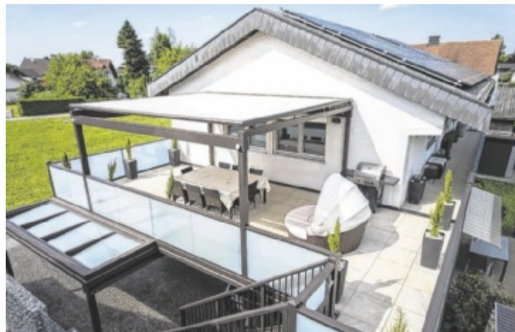
Individueller Anbaubalkon mit Überdachung und Stiegenaufgang
