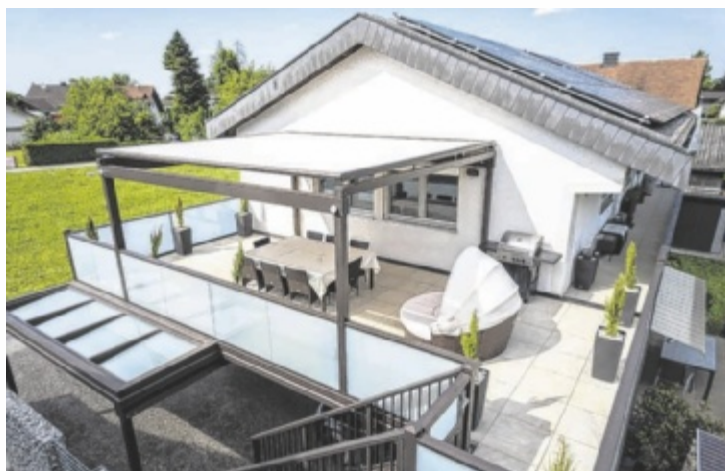
Individueller Anbaubalkon mit Überdachung und Stiegenaufgang
