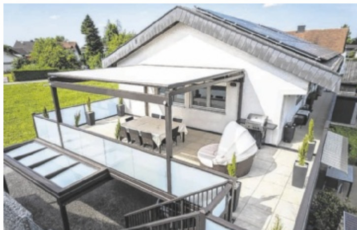
Individueller Anbaubalkon mit Überdachung und Stiegenaufgang
