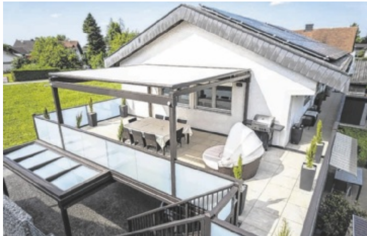
Individueller Anbaubalkon mit Überdachung und Stiegenaufgang
