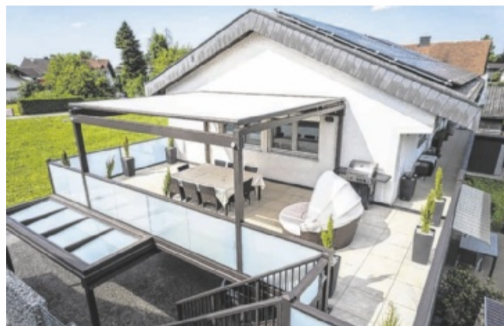
Individueller Anbaubalkon mit Überdachung und Stiegenaufgang
