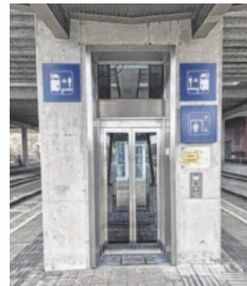
Die beiden erneuerten Aufzüge am Steyrer Bahnhof sind seit Anfang April wieder in Betrieb. Foto: ÖBB/Manfred Gruber
