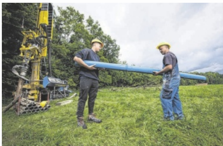
Brunnenbauer sind essentiell für die heimische Wasserversorgung.
