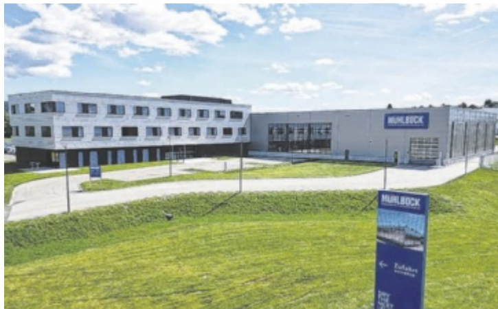
Rund 100 Mitarbeiter arbeiten am neuen Mühlböck-Standort in Eberschwang / Antiesen.
