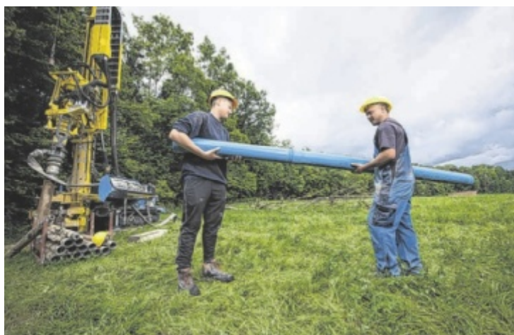
Brunnenbauer sind essentiell für die heimische Wasserversorgung.
