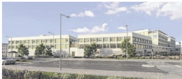
Am MedCampus entsteht für die Versorgung der Patienten und Beschäftigten bis 2028 die größte Küche des Landes (Rendering).
