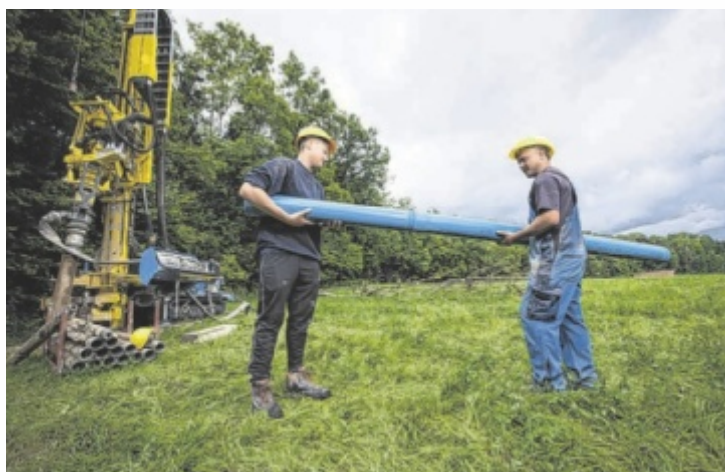
Brunnenbauer sind essentiell für die heimische Wasserversorgung.
