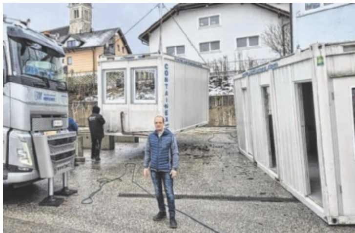
Der Startschuss fiel im Februar 2026 mit der Versetzung eines Containers. Foto: Gebeshuber
