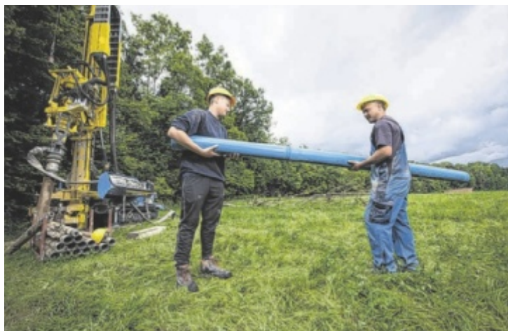
Brunnenbauer sind essentiell für die heimische Wasserversorgung.
