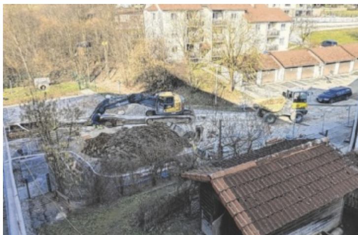
Die Arbeiten sind schon in vollem Gange.
