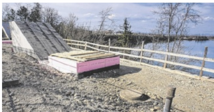
Die Erwärmung der Enns durch die Kühlung ist vernachlässigbar.
