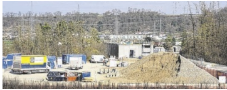
Der aktuelle Stand der Google-Baustelle (25. März 2026)
