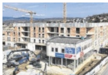
Die Baustelle in Straßham Fotos: OÖ Wohnbau
