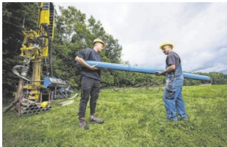
Brunnenbauer sind essentiell für die heimische Wasserversorgung.
