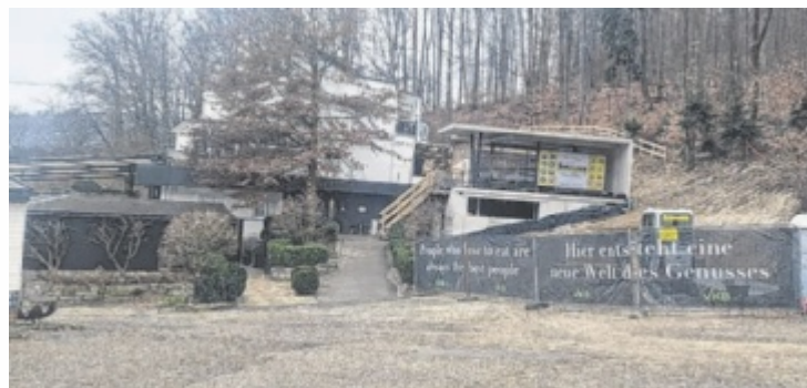
Seit Oktober wird umgebaut, der Betrieb läuft normal weiter.
