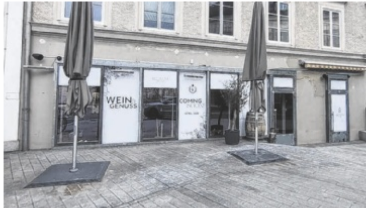
dasKlamm. eröffnet Mitte April, noch laufen die Umbauarbeiten. Foto: Tips/Seyringer
